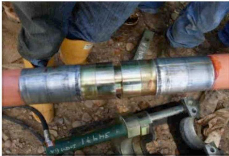
**Splice – Unión Secciones**
